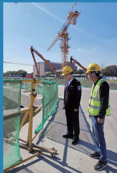
建筑工地施工现场检查
