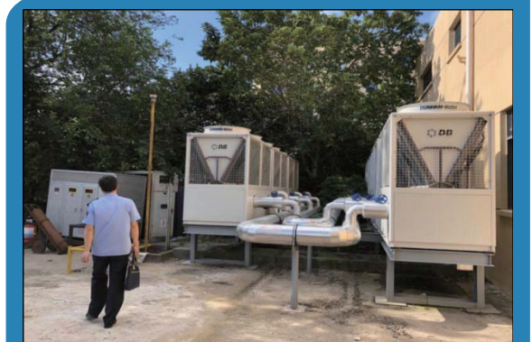
现场检查锅炉改造
