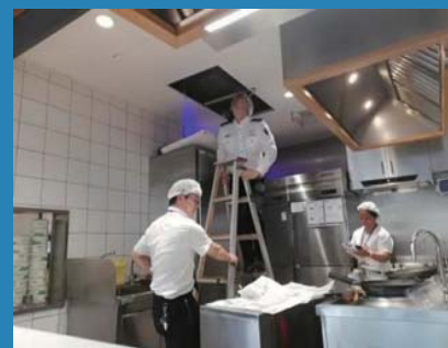
厨房烟道检查
