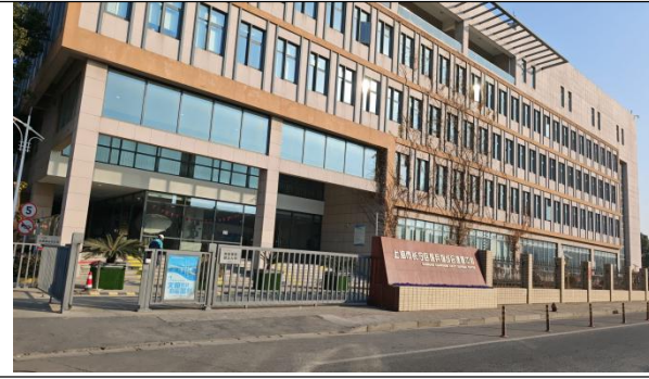
厂区东大门及综合楼
