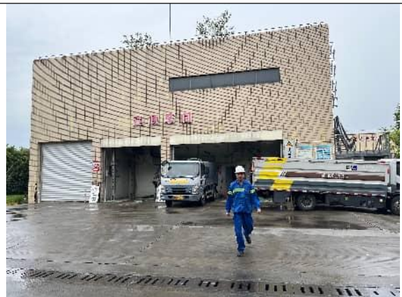
厂区内现状粪便预处理车间
