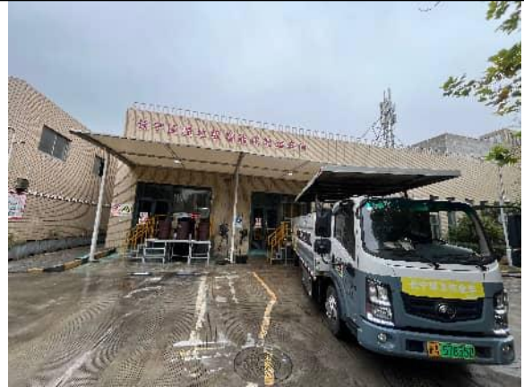
厂区内湿垃圾中转车间
