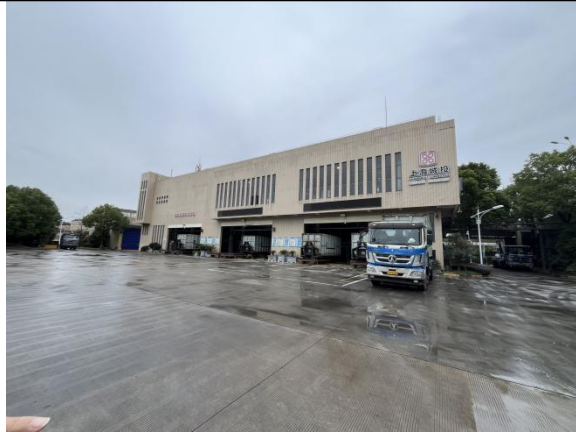
厂区内现状生活垃圾中转车间
