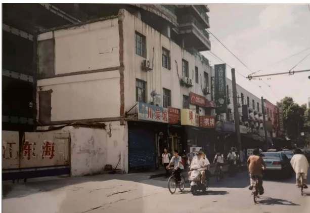
▲伟兴房产开发的综合楼出现烂尾
