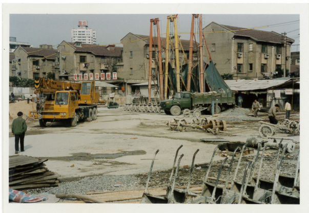
▲长宁工人俱乐部地块开发房地产，图为施工现场
