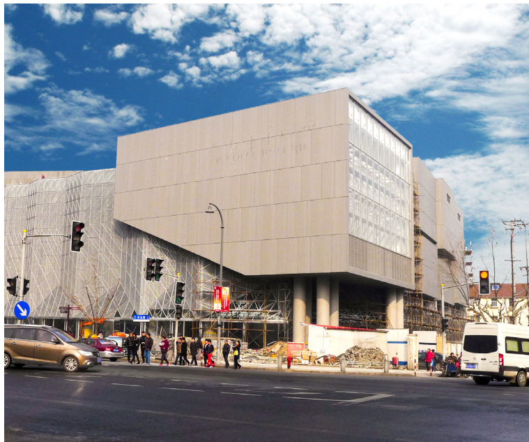
2016年元月虹桥艺术中心脱下脚手架，进入工程扫尾。（摄影 姚志康）
